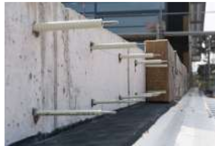
Isolink składa się z pręta Combar i śruby ze stali nierdzewnej. Fot. Schöck
