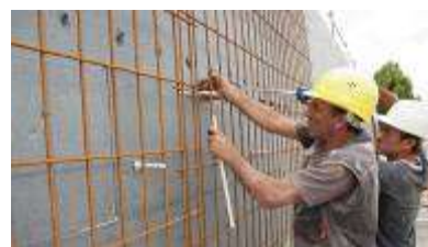
Kotwy Isolink dedykowane są do ścian sandwichowych Fot. Schöck
